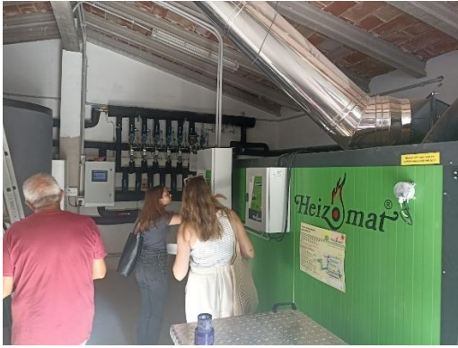
INSTALACION CALDERA DE BIOMASA HOTEL FONT DEL PAS
