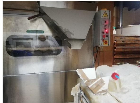
MODERNIZACION PANADERIA EN CASTELSERAS
