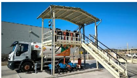
ALMACEN y distribución DE COMBUSTIBLES (Acorisa)
