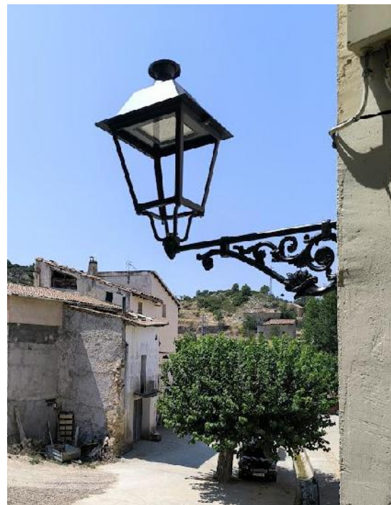
RENOVACION DE ALUMBRADO PUBLICO MEJORA LUMINICA Y EFICIENCIA ENERGETICA (Las Parras de Castellote)
