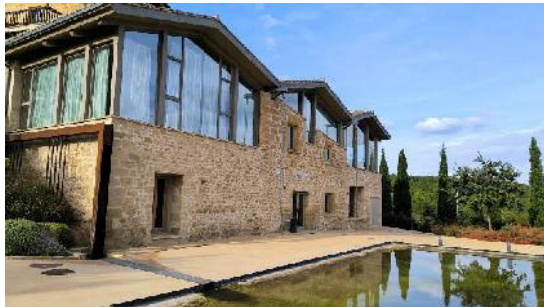
MEJORAS EN HOTEL TORRE DEL MARQUES (Monroyo)
