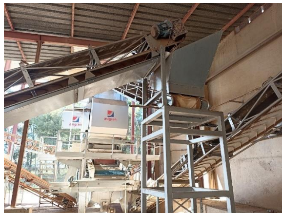
NUEVA PLANTA DE LIMPIEZA Y CLASIFICADO ACEITUNA EMPELTRE EN ALCAÑIZ
