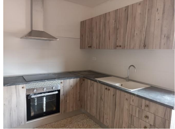
Rehabilitación vivienda en Peñarroya de Tastavins
