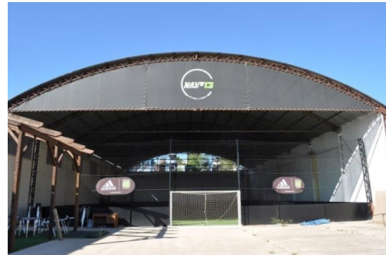
2019.10.2.017 INSTALACION PADEL Y FUTBOL INDOOR EN ALCAÑIZ
