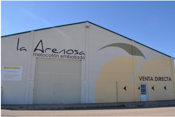
2019.10.2.038 MODERNIZACION DE LINEA DE TRANSFORMACION Y VENTA DE MELOCOTON DE CALANDA
