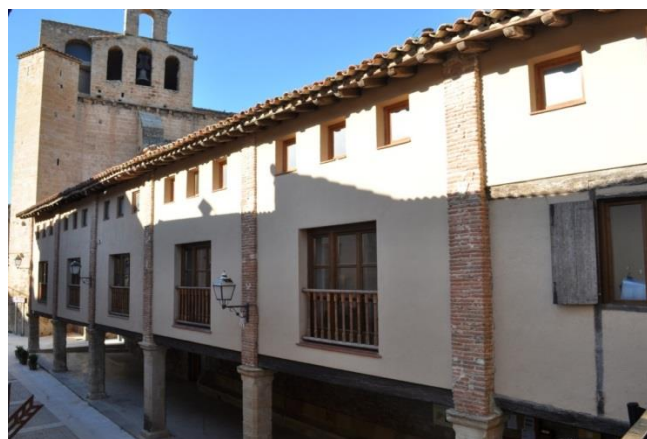
2018.10.2.065 MEJORA DEL ENVOLVENTE TERMICA DEL EDIFICIO Ayto de Ráfales
