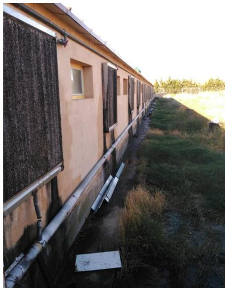
*Imagen 19. Paneles de refrigeración*
