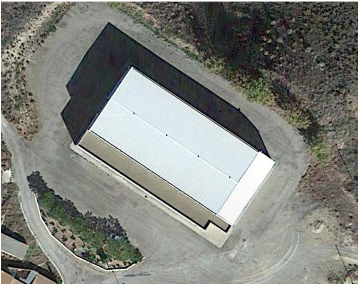
Ilustración 4. Ubicación de la instalación fotovoltaica
