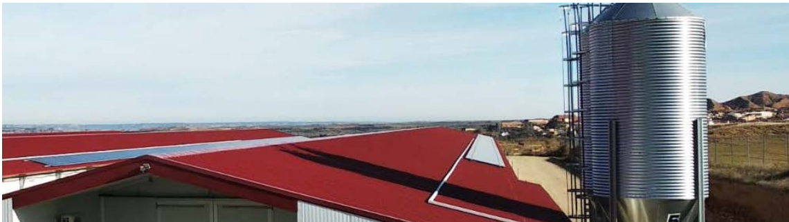
Ilustración 1. Ejemplo de instalación fotovoltaica de autoconsumo sobre tejado
