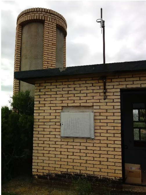
Elevación aguas pozo
