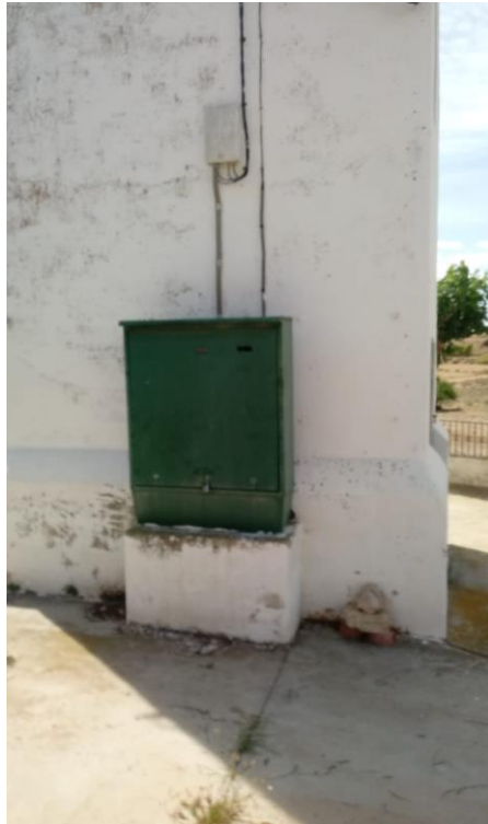
Figura 1. Contador alumbrado
