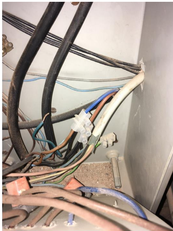
Circuitos sin seccionamiento.
