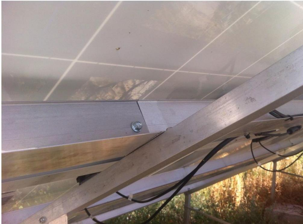
1. Los anclajes de sujeción entre paneles tienen una holgura de 5mm, lo que permite desplazar los paneles lateralmente.
