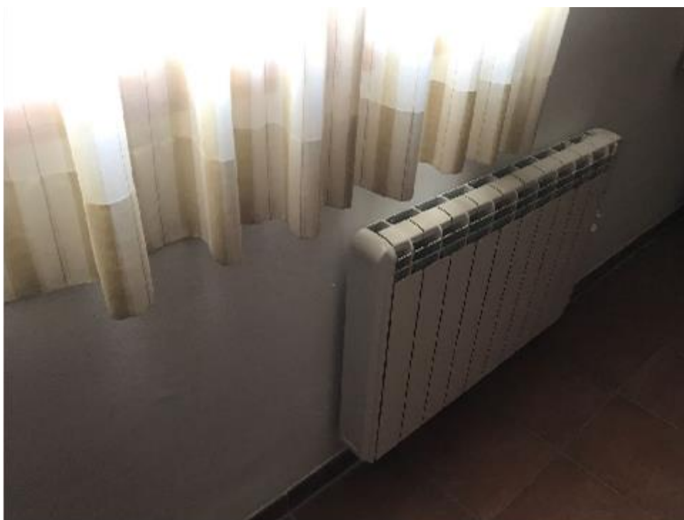
Sustitución radiadores eléctricos por caldera de biomasa
