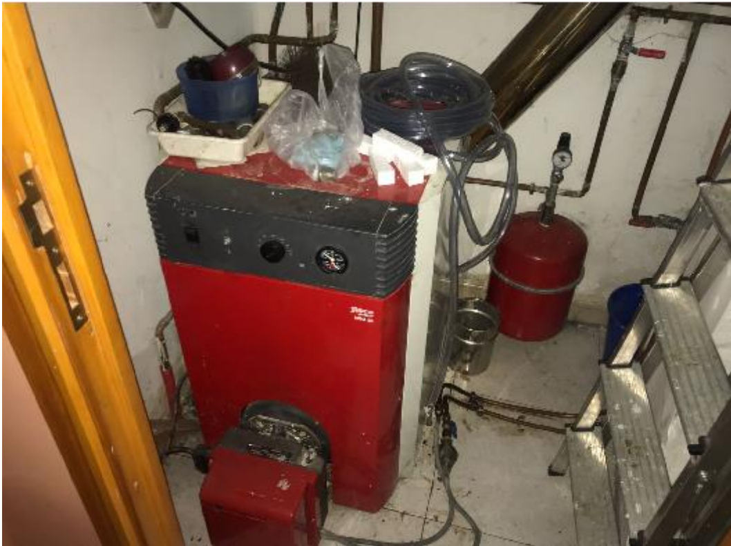
Sustitución caldera Gasóleo por caldera de biomasa
