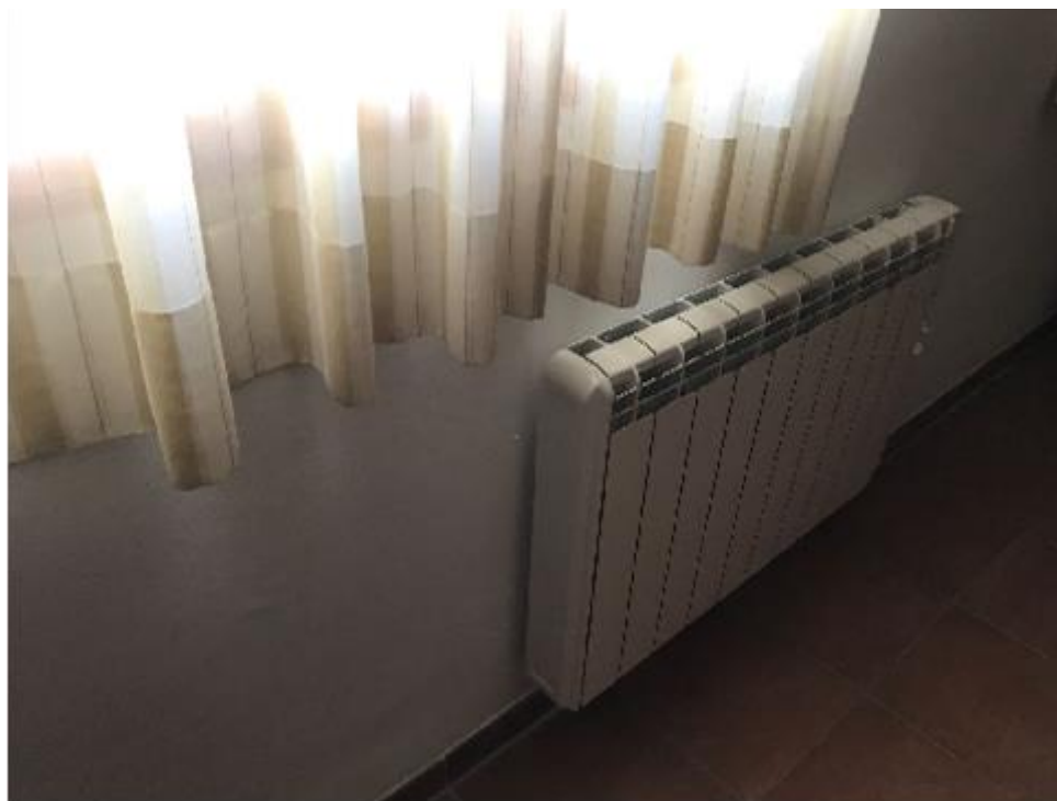
Sustitución radiadores eléctricos por caldera de biomasa
