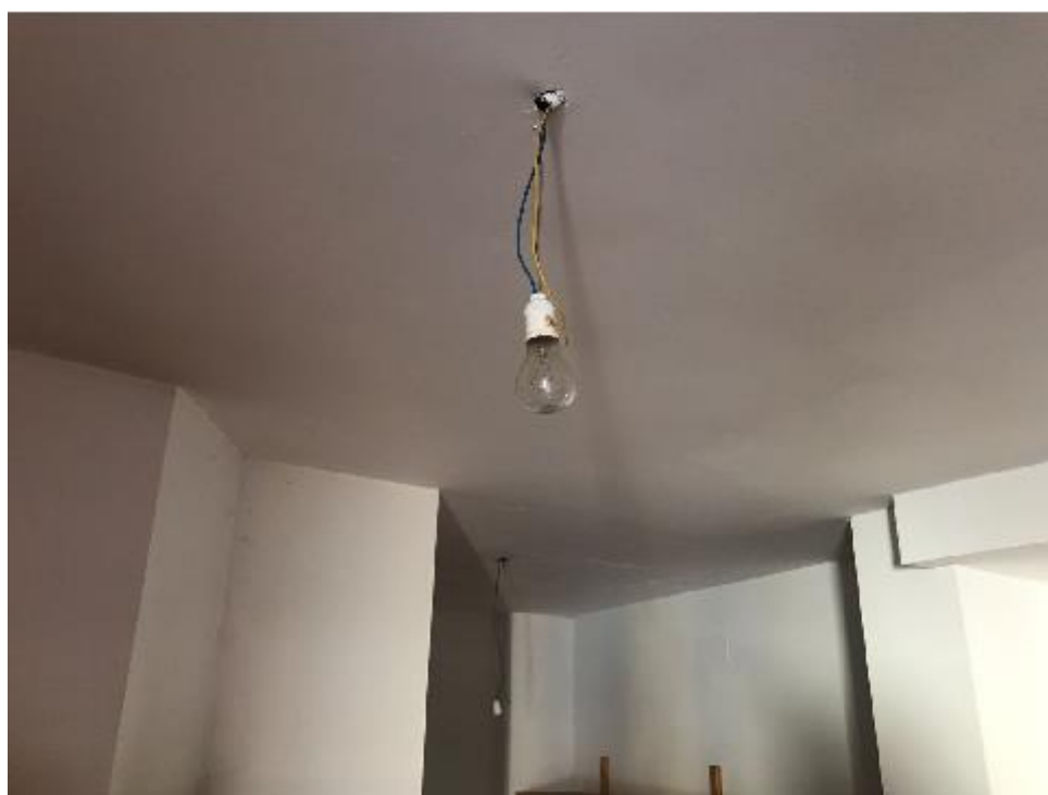
Sustitución de bombillas de incandescencia por bombillas de led
