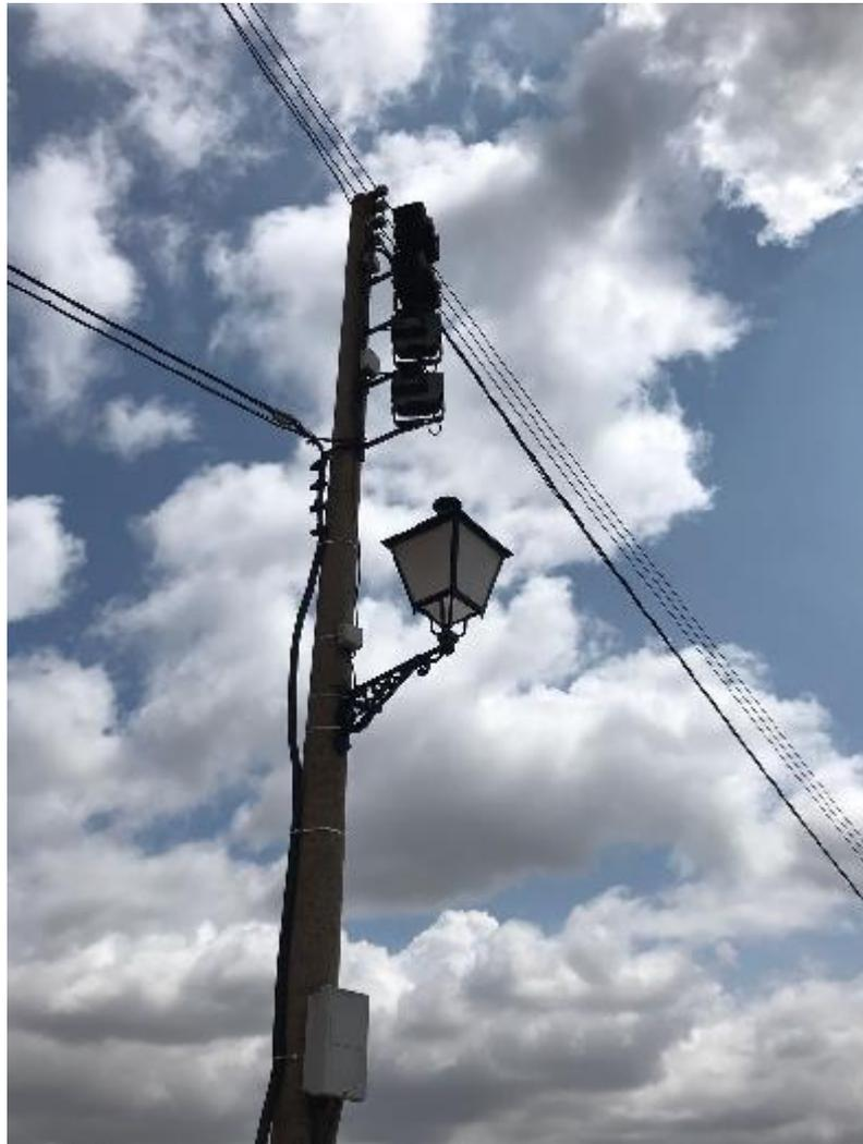
Sustitución de bombillas de sodio 150W a bombillas Leds de 26W.
