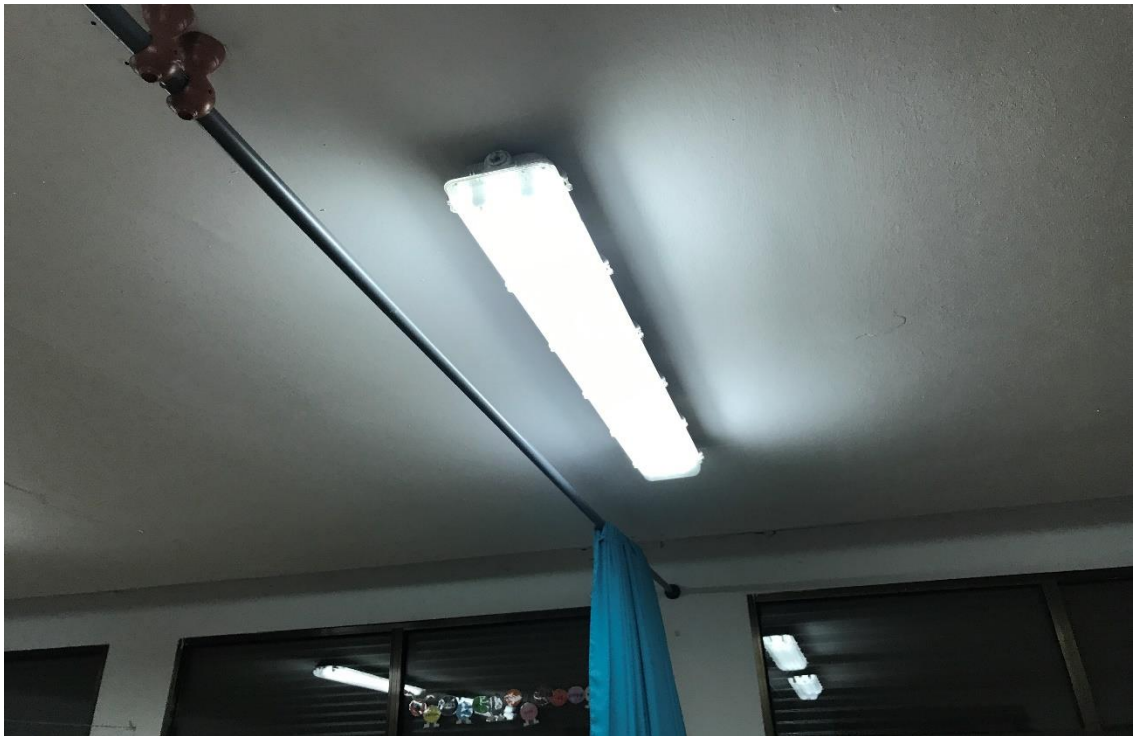
Sustitución de bombillas de incandescencia por bombillas de led
