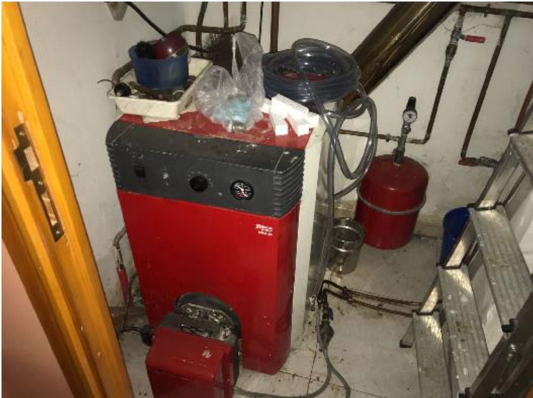
Sustitución caldera Gasóleo por caldera de biomasa
