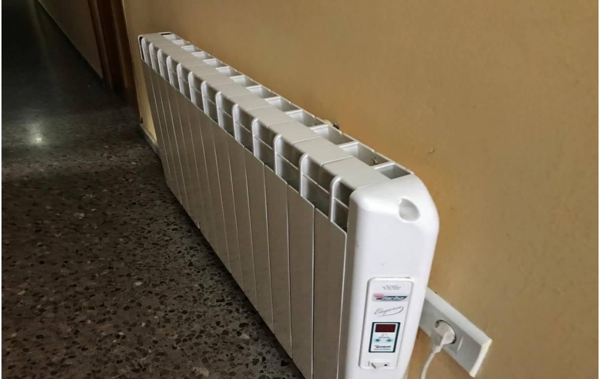
Sustitución radiadores eléctricos por caldera de biomasa
