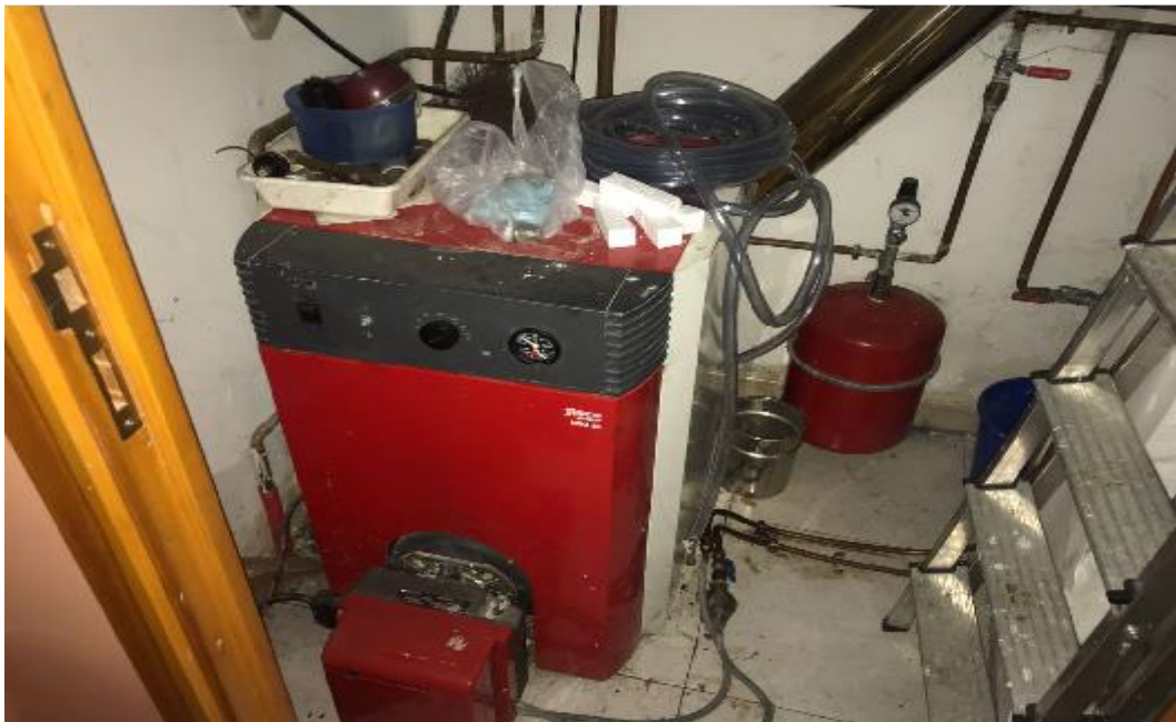
Sustitución caldera Gasóleo por caldera de biomasa
