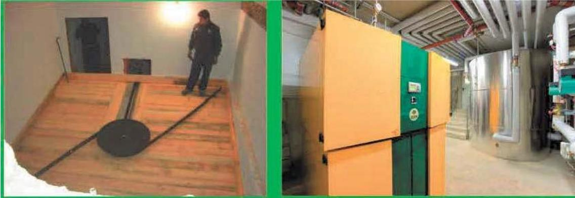
Ilustración 12. Caldera, sala de calderas y removedor
