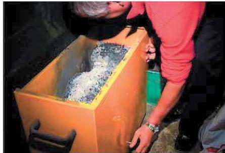
Ilustración 10. Instante de la extracción del cenicero de una caldera automática de biomasa
