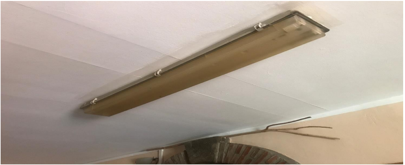
Sustitución la iluminación a led.
