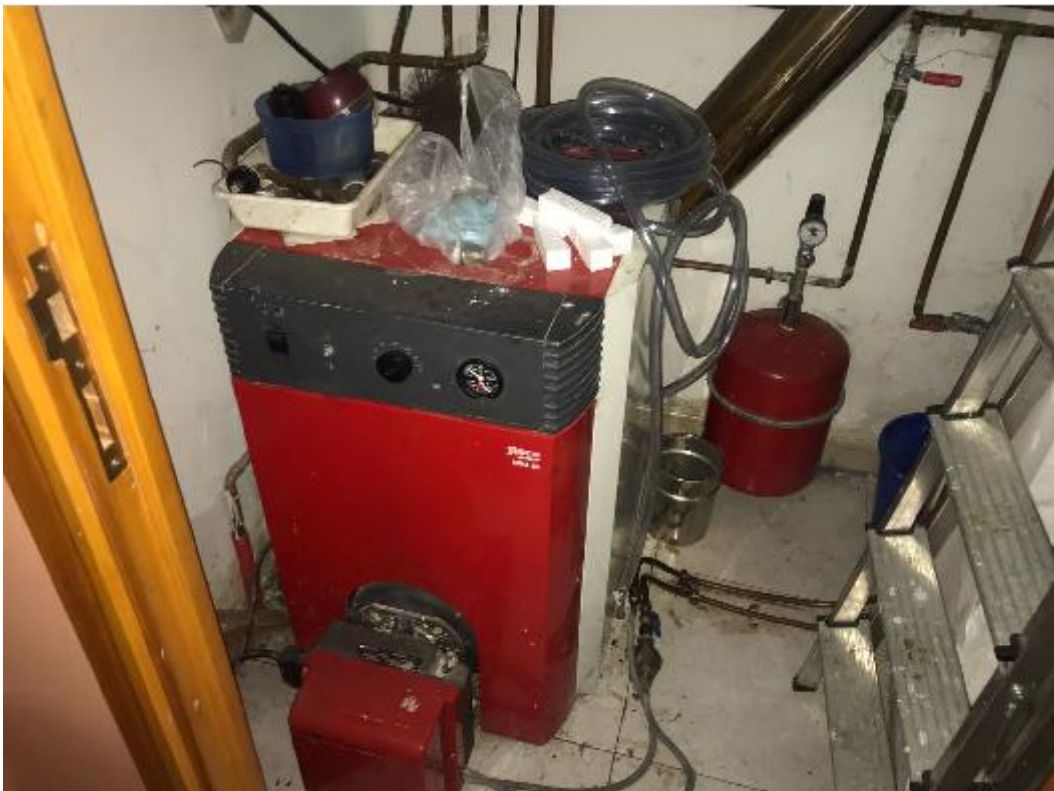
Sustitución caldera Gasóleo por caldera de biomasa
