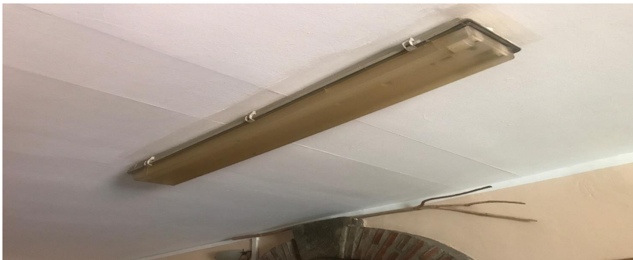
Sustitución la iluminación a led.
