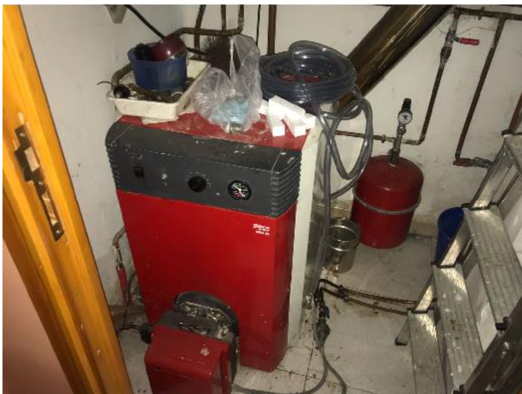
Sustitución caldera Gasóleo por caldera de biomasa
