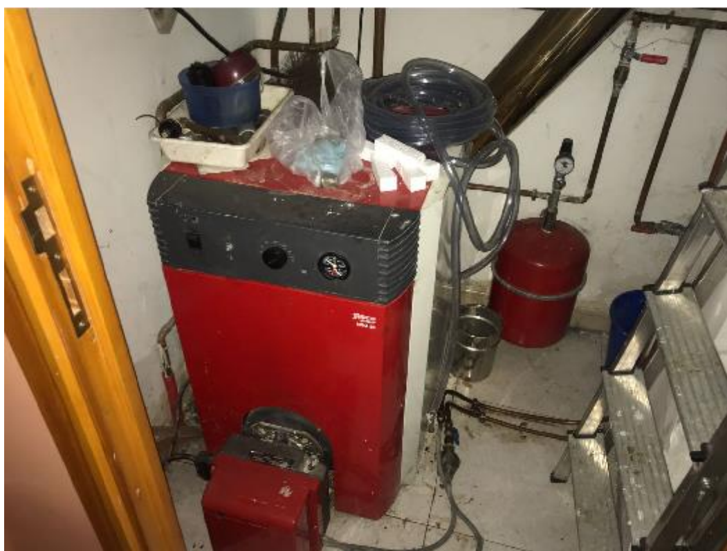
Sustitución caldera Gasóleo por caldera de biomasa
