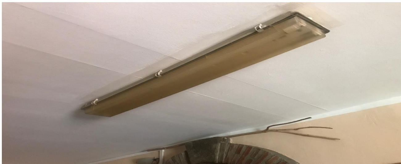
Sustitución la iluminación a led.
