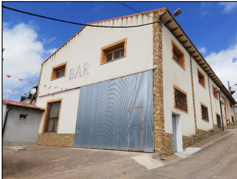
Foto 8: Fachada principal con orientación SUR donde se aprecia el portón de acceso al Pabellón.
