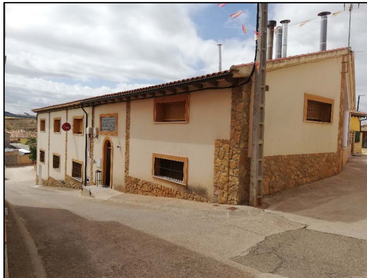
Foto 2: Fachada con orientación ESTE.
