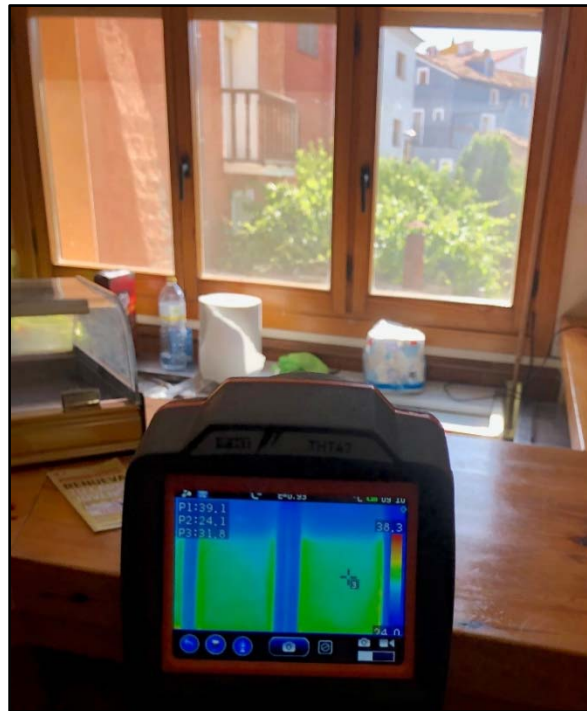
Foto 4: Imagen termográfica de la ventana por la parte interior.
