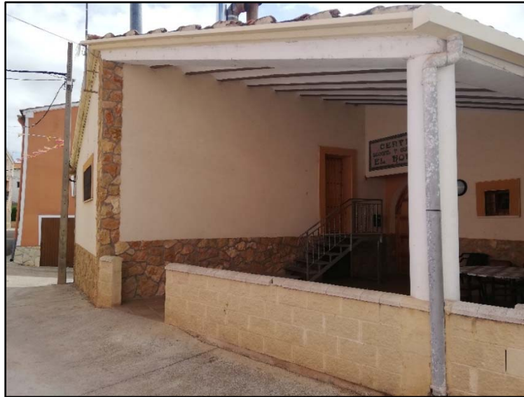
Foto 7: Fachada principal con orientación NORTE.
