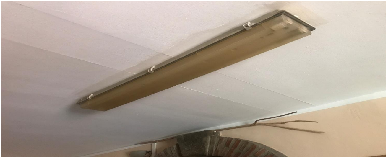
Sustitución la iluminación a led.
