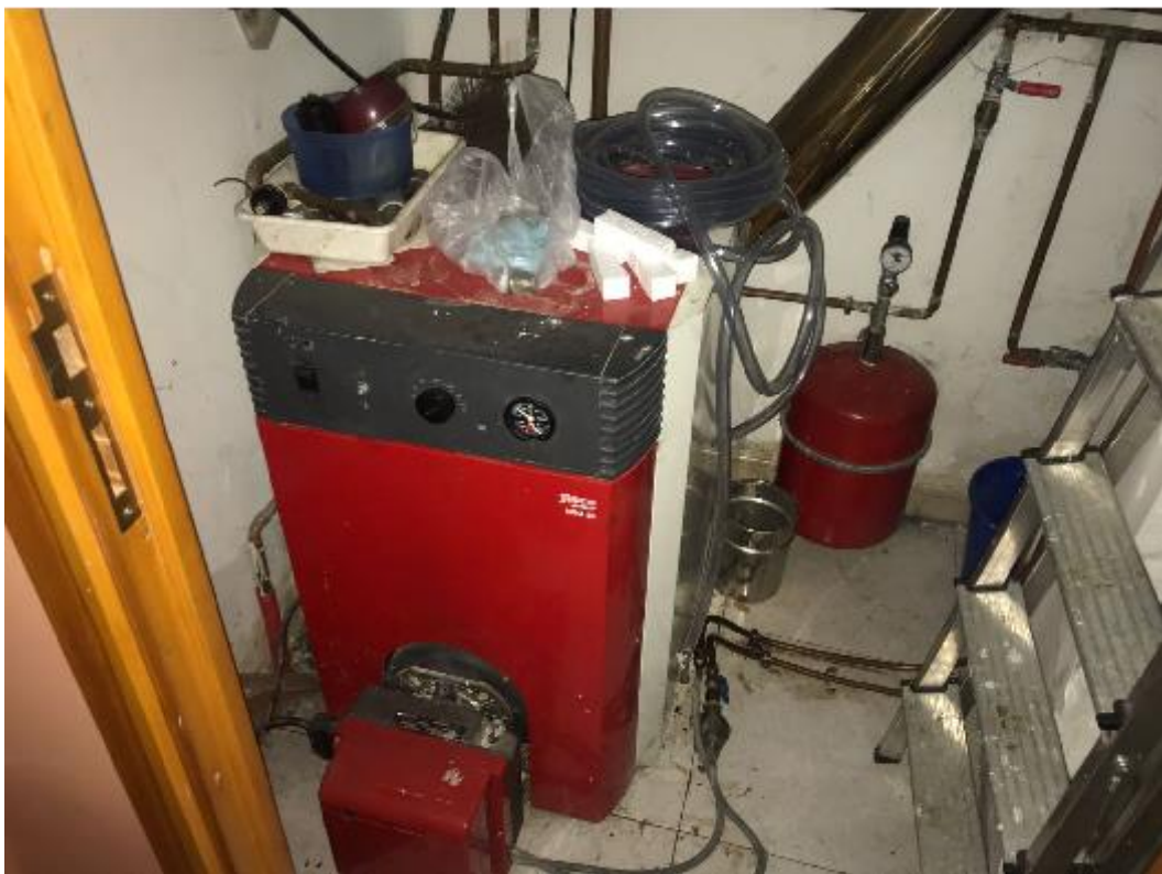
Sustitución caldera Gasóleo por caldera de biomasa
