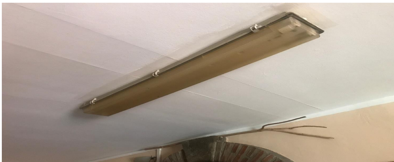
Sustitución la iluminación a led.
