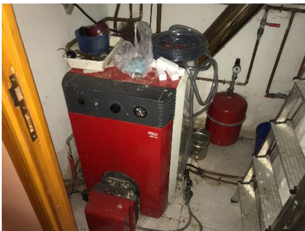
Sustitución caldera Gasóleo por caldera de biomasa
