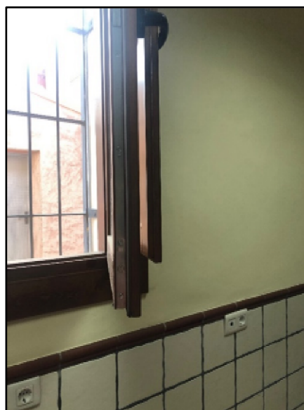
Foto 1: Carpinterías de exterior recientemente sustituidas.
