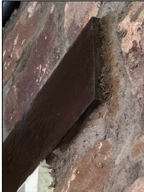
Foto 4: Tapeta de madera existente en el exterior como revestimiento de los cabeceros donde se detectan puntos calientes en fachada ubicada a la sombra en el momento de la toma de la imagen termográfica.
