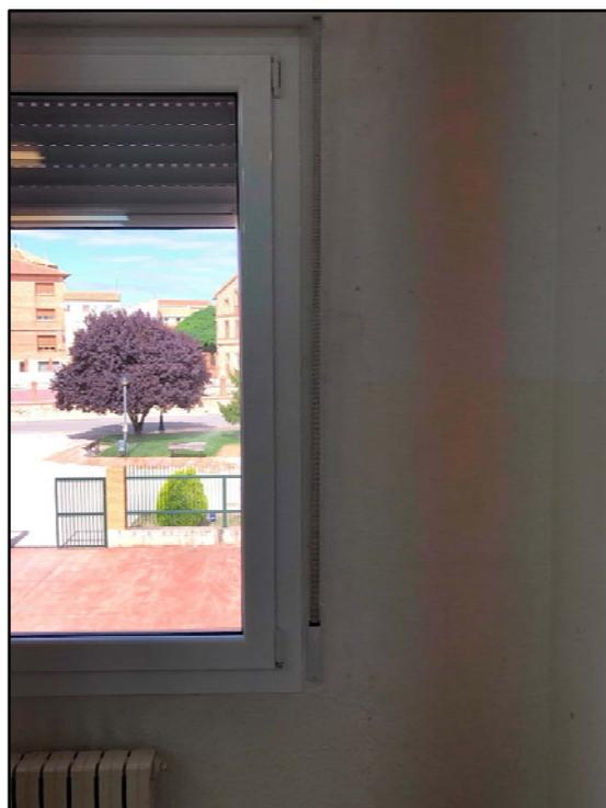
**Foto 14:** Ventanas nuevas instaladas recibidas con yeso en los laterales donde se detectan puntos fríos y con bastante diferencia de temperatura con los vidrios y el resto de paramentos.
