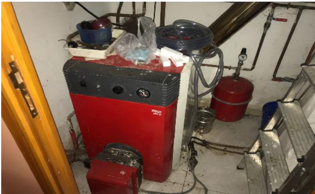
Sustitución caldera Gasóleo por caldera de biomasa
