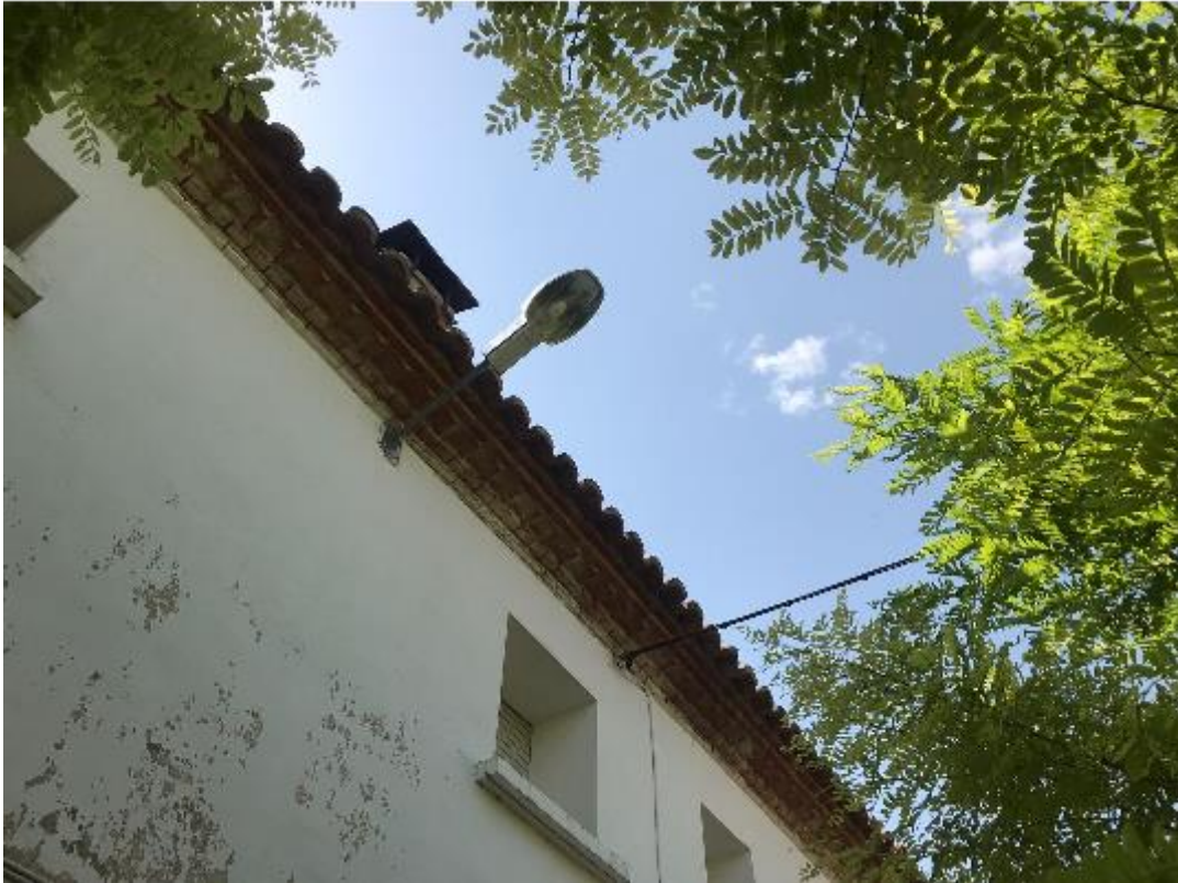
Alumbrado público, sustitución de bombillas a otro tipo LEDS.
