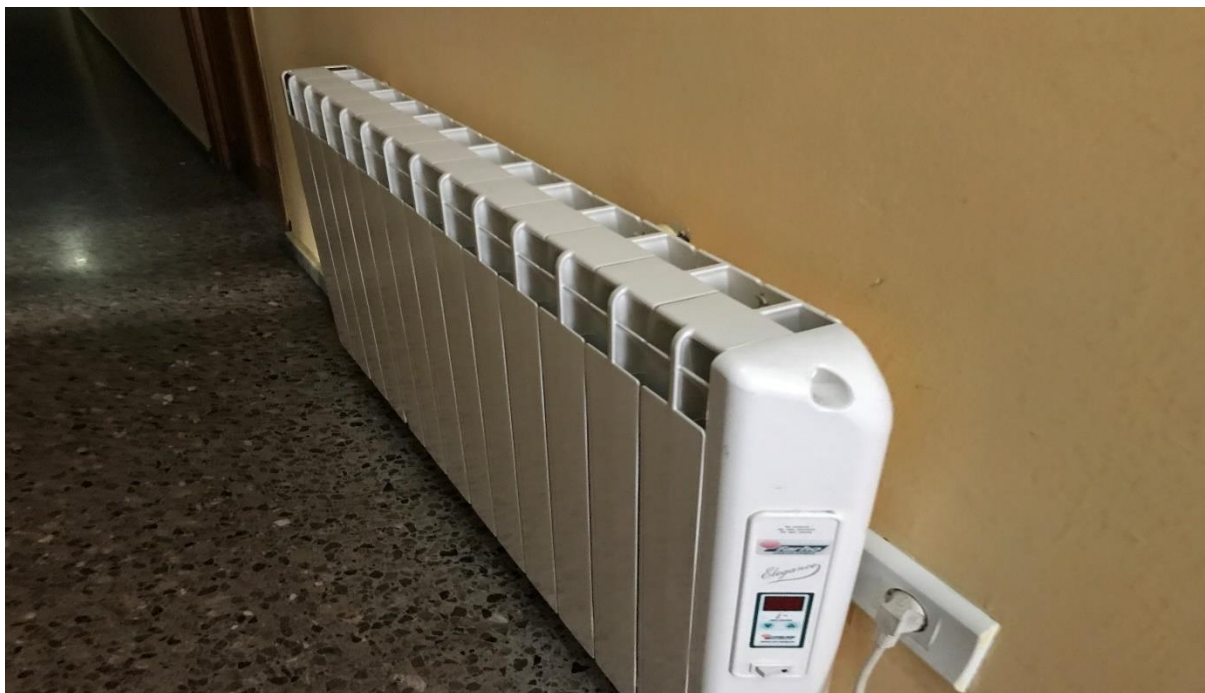
Sustitución radiadores eléctricos por acumuladores o a calefacción con biomasa.
