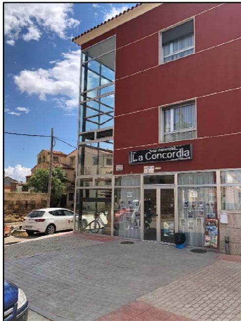
**Foto 2:** Fachada principal con orientación NOROESTE, donde se aprecia la cantidad de acristalamiento existente en la fachada.
