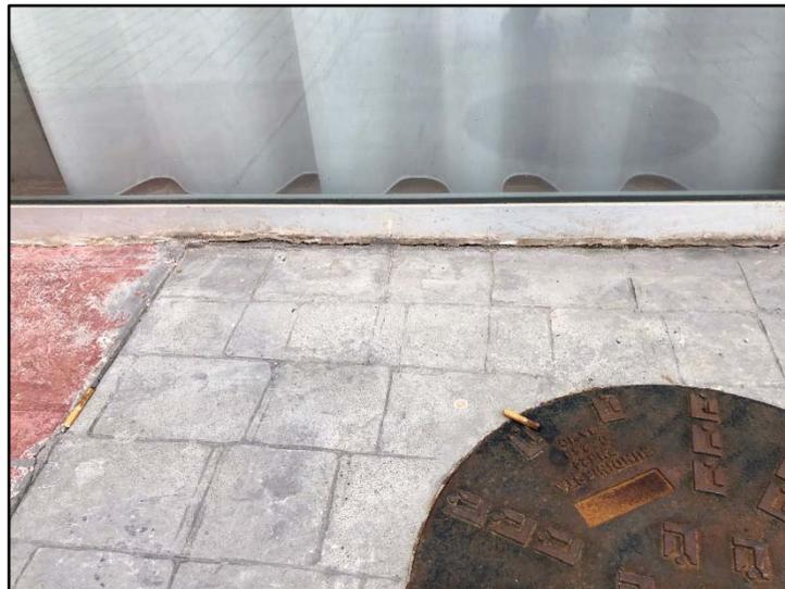
**Foto 6:** Imagen del sellado y recibido de las carpinterías de exterior con los paramentos existentes.
