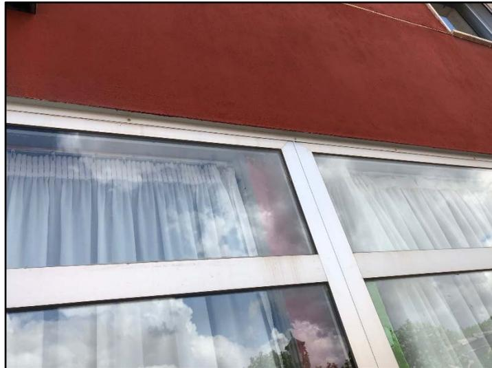
**Foto 7:** Imagen del sellado y recibido de las carpinterías de exterior con los paramentos existentes.
