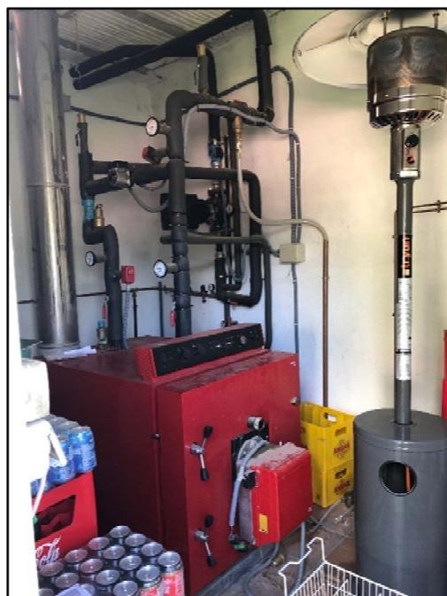
**Foto 11:** Caldera de gasoil ROCA modelo CPA-100 de 116,3 kW.
