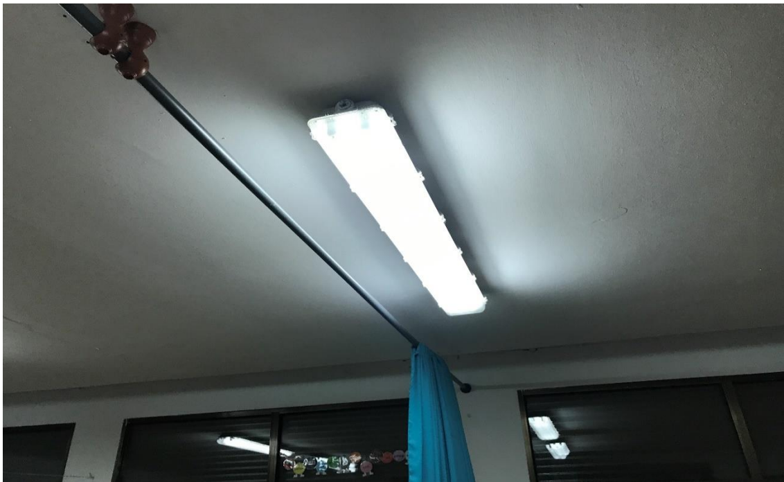
Sustitución de bombillas de incandescencia y tubos fluorescentes por otros de LEDS.
