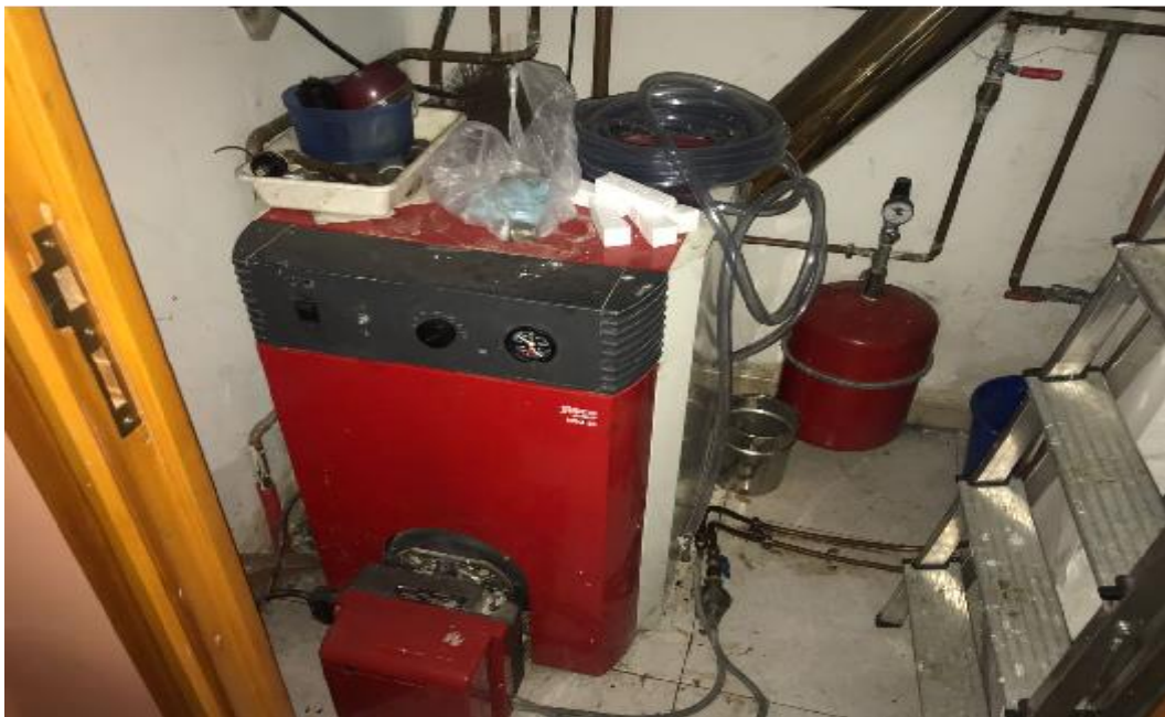
Sustitución caldera Gasóleo por caldera de biomasa
