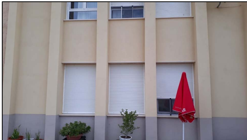
Foto 12: Foto de acabado final de otra de las fachadas, también realizada con el mismo aislamiento de la fachada.
