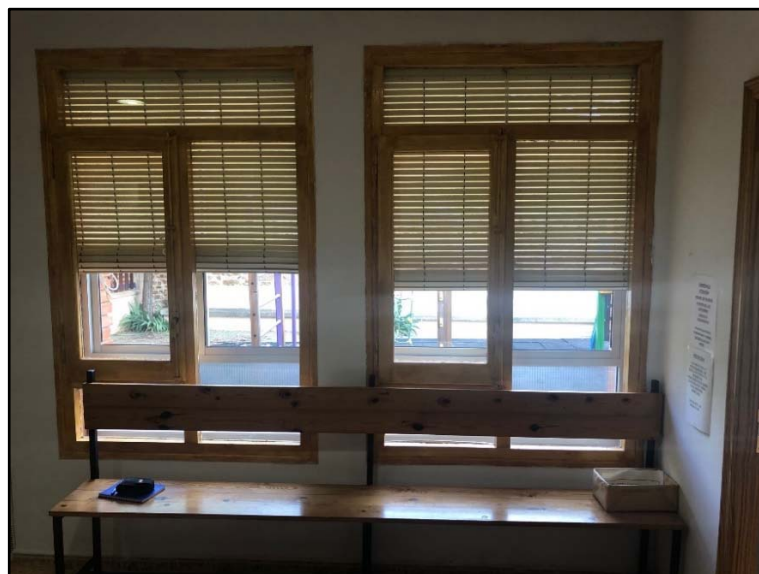
Foto 4: Carpintería interior de la fachada Sur de la Planta baja del Edificio.
