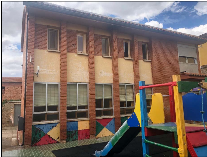
Foto 1: Fachada Sur del Edificio Multiusos
