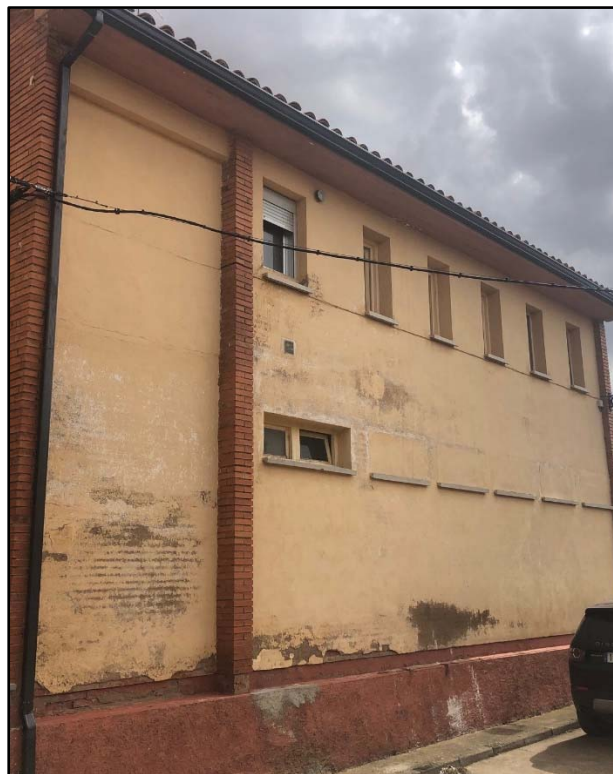
Foto 2: Fachada Norte del Edificio Multiusos
