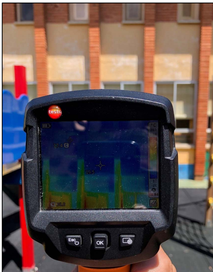
Foto 5: Termografía de la fachada Sur realizada por la mañana cuando el sol incide directamente en ella.
