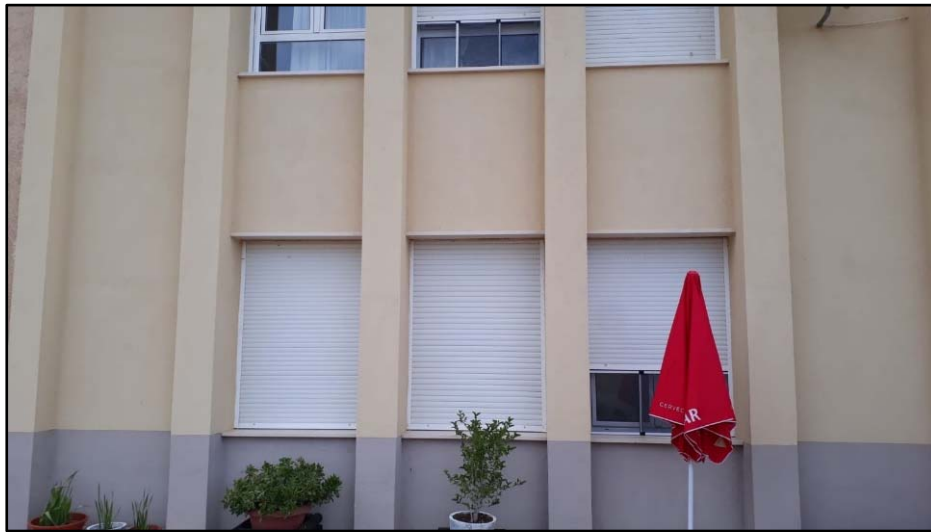
Foto 17: Foto de acabado final de otra de las fachadas, también realizada con el mismo aislamiento de la fachada.
