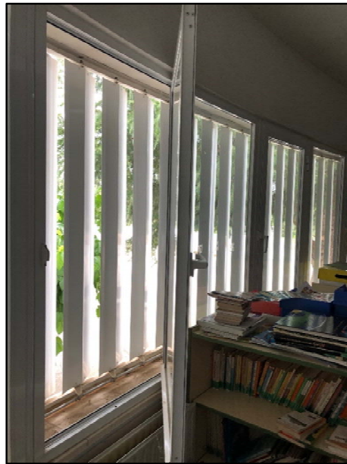
Foto 8: Fotografía de la carpintería y lamas orientables de protección solar.
