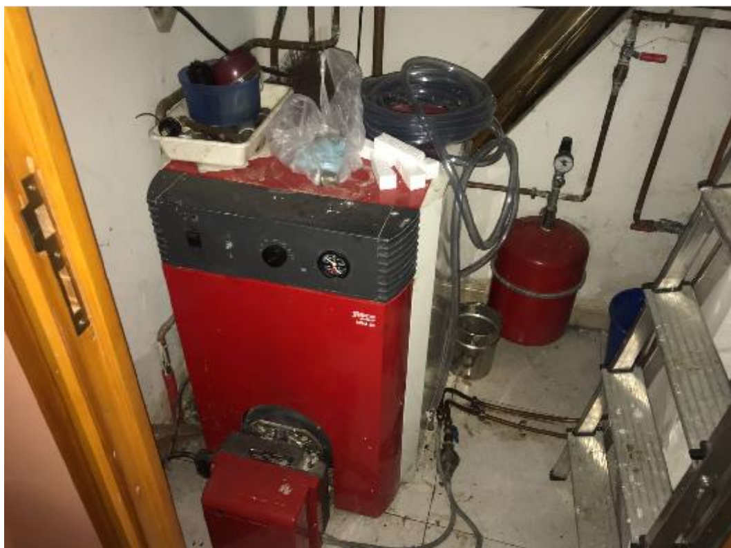
Sustitución caldera Gasóleo por caldera de biomasa
