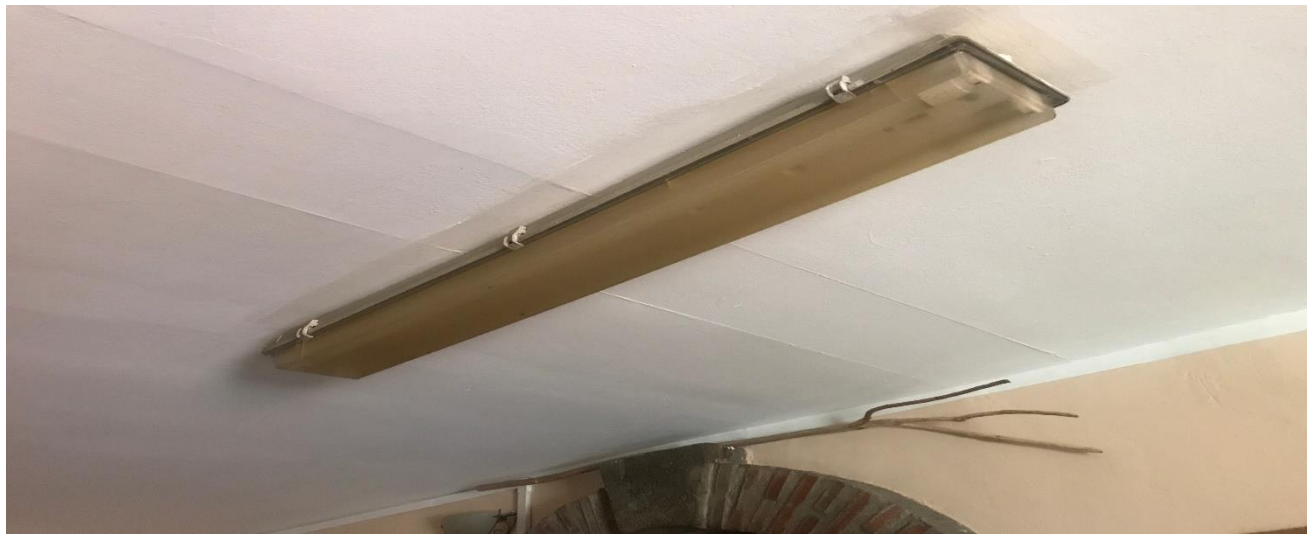
Sustitución la iluminación a led.
