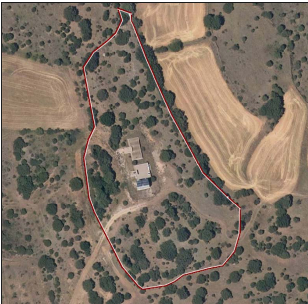
Foto 1: Emplazamiento de la planta potabilizadora.
