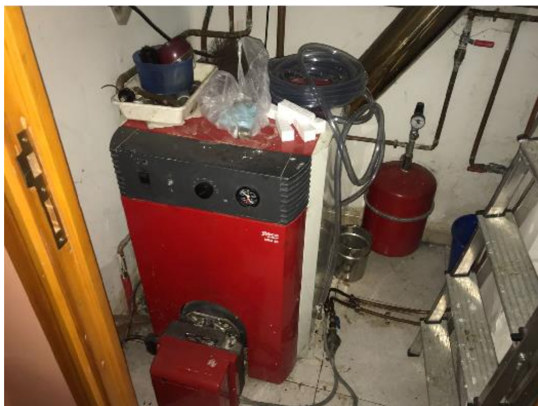
Sustitución caldera Gasóleo por caldera de biomasa
