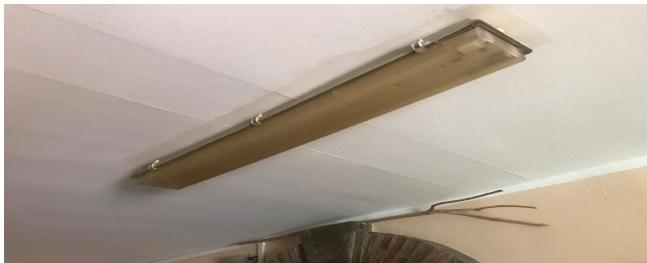
Sustitución la iluminación a led.
