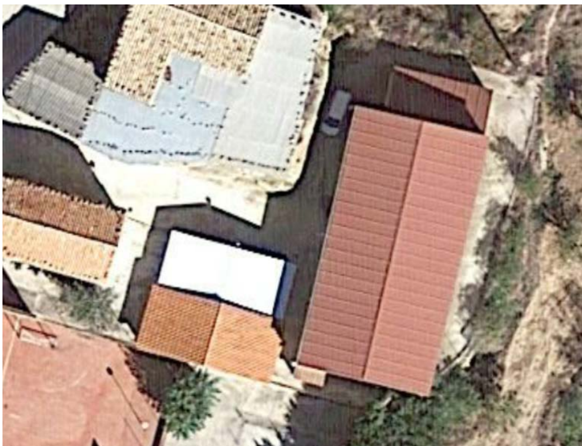
Ilustración 10. Ubicación de la instalación fotovoltaica
