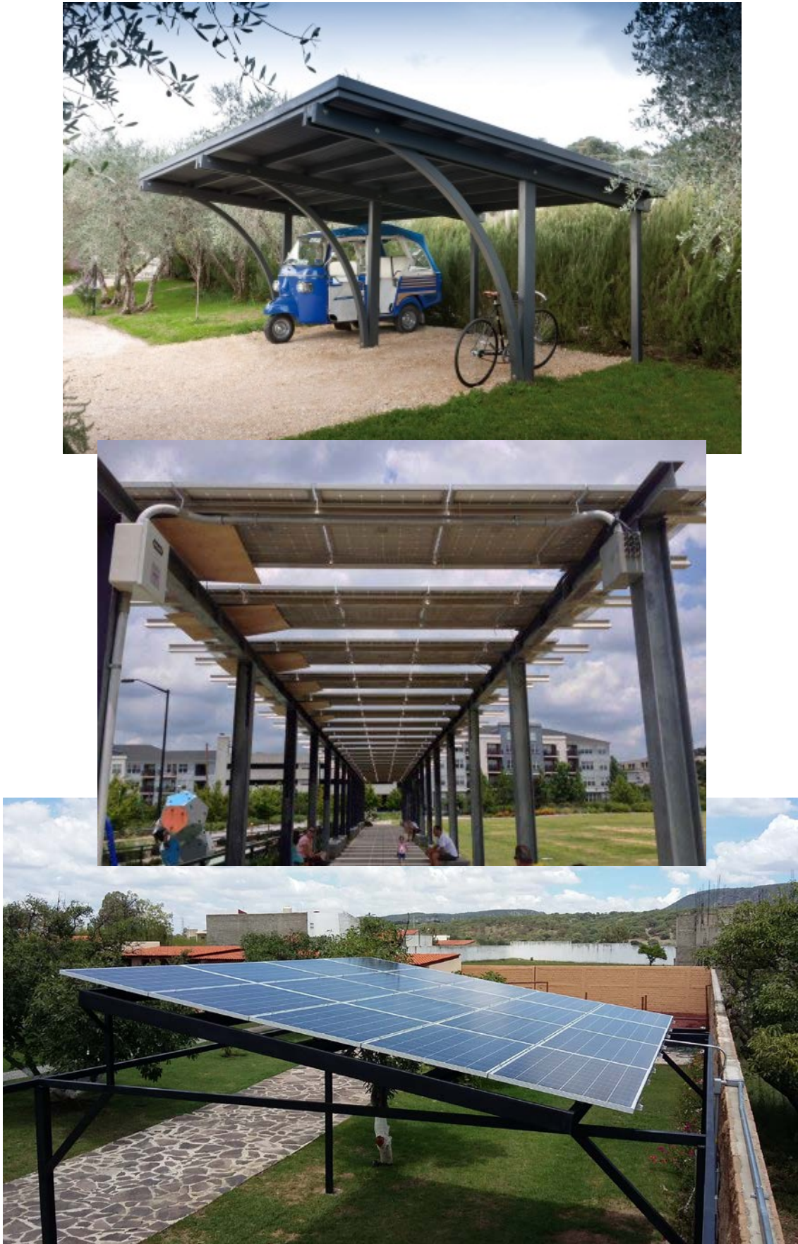
Ilustración 15. Ejemplos de estructuras para sombras con módulos fotovoltaicos
