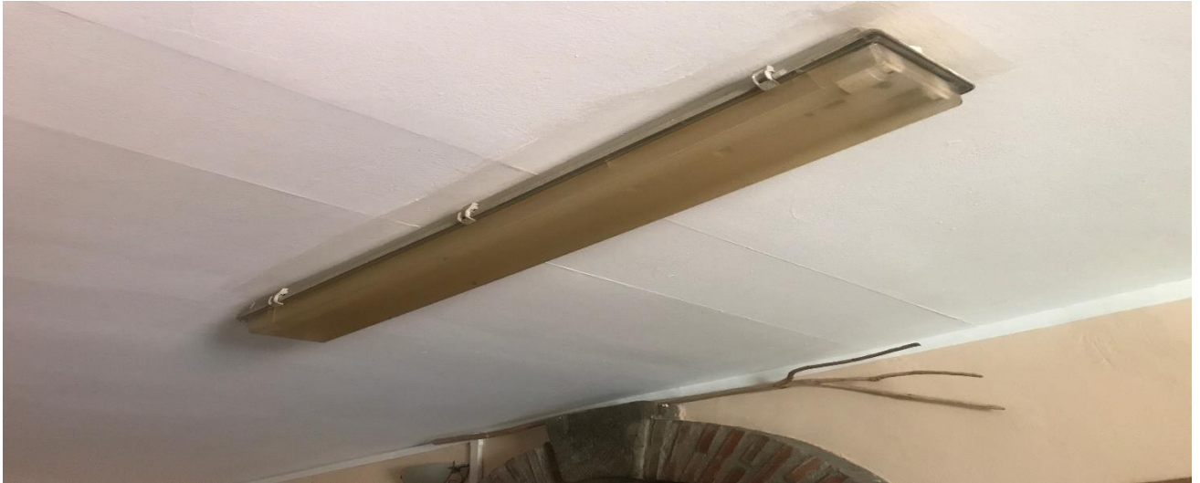
Sustitución la iluminación a led.
