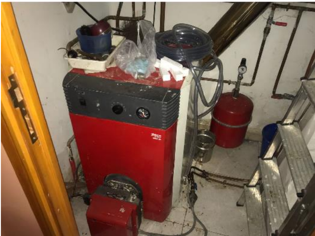
Sustitución caldera Gasóleo por caldera de biomasa
