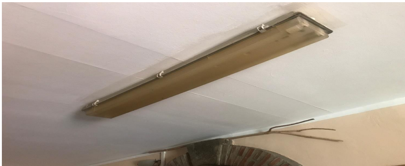
Sustitución la iluminación a led.
