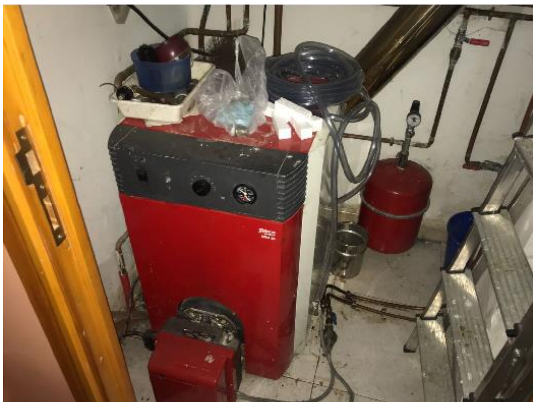
Sustitución caldera Gasóleo por caldera de biomasa
