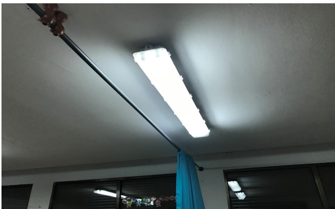
Sustitución de bombillas de incandescencia y tubos florecientes por otros de LEDs.
