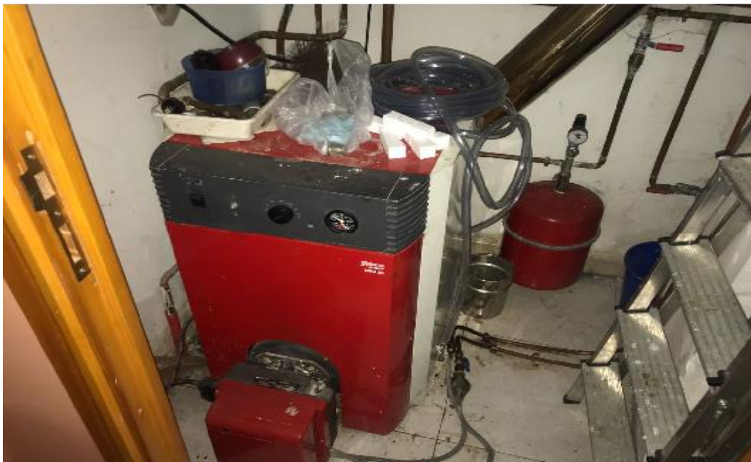
Sustitución caldera Gasóleo por caldera de biomasa
