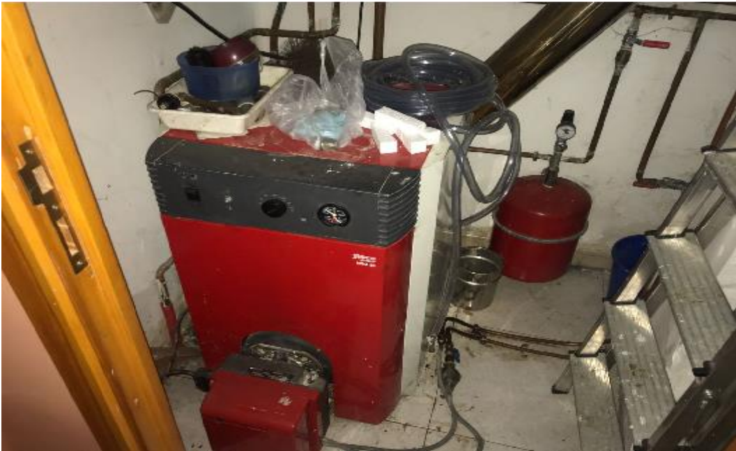
Sustitución caldera Gasóleo por caldera de biomasa
