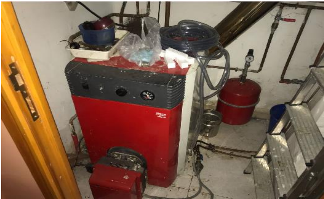
Sustitución caldera Gasóleo por caldera de biomasa
